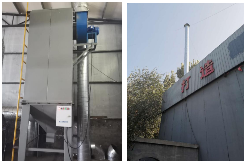
图 4-1 布袋除尘器+15m 高排气筒
